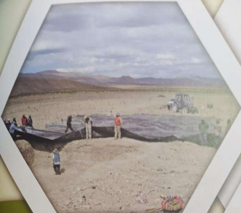
PREPARADO DE POLICARBONATO PARA ESTANQUE DE RIEGO.
