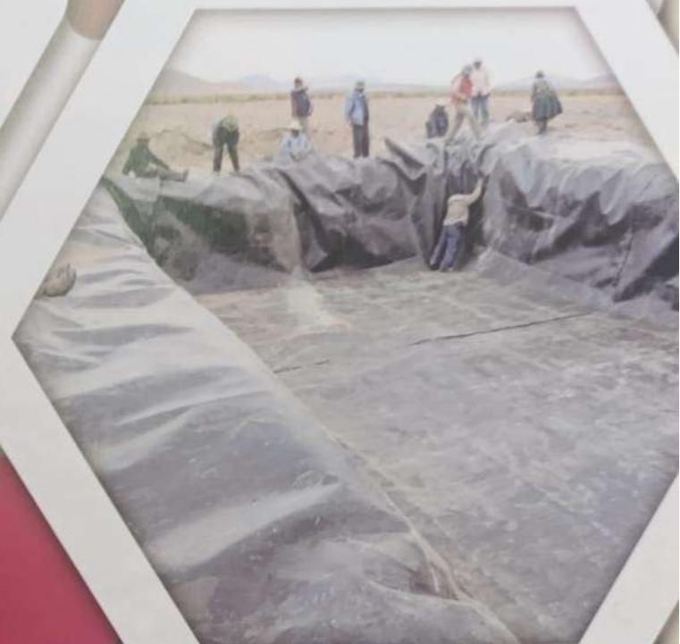
ALMACENAMIENTO DE AGUA DE RIEGO CON POLICARBONATO.
