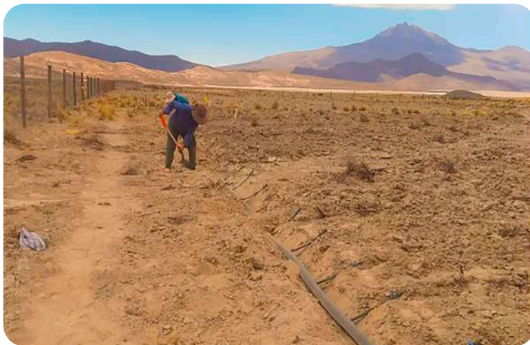
Foto: Excavado y enterrado del lateral de riego en la parcela Marka Vinto GAIOC-SA (Oruro)
