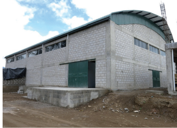
Imagen 4: Planta quinuera de la organización Coprobich en construcción en el año 2013 © Jean-Philippe Noel
