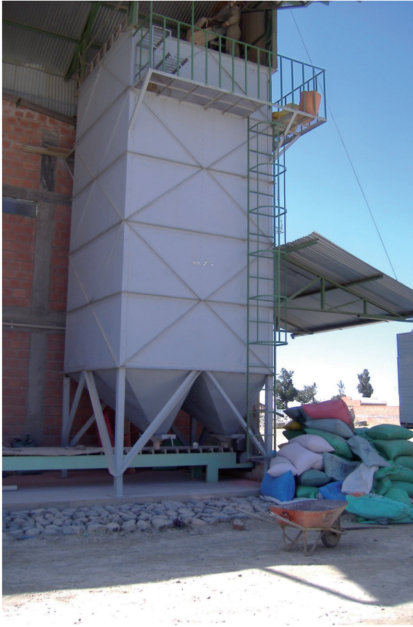
Figura 19: Silos de almacenamiento de la empresa Complejo Industrial y Tecnológico Yanapasiñani S.R.L. (CITY) (Cortesía: UPB)
